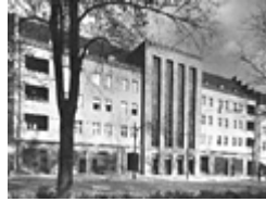
Gemeindehaus Albrechtstraße Außenansicht, um 1930
